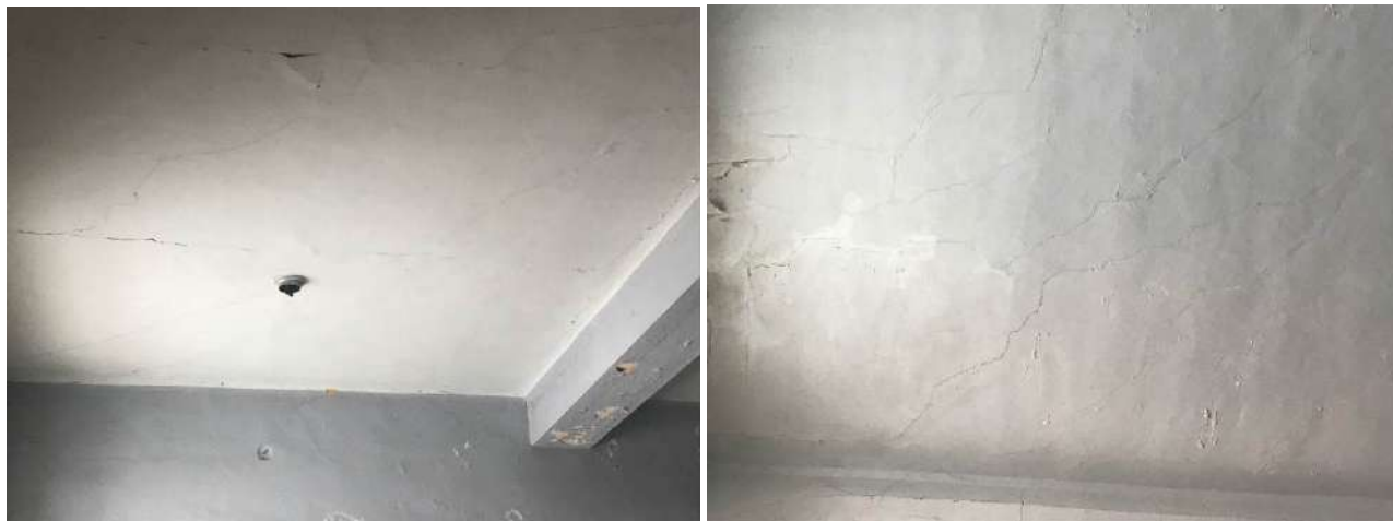
Sliki 12 in 13: Tipične razpoke stropnih ometov na lesenih medetažnih konstrukcijah
