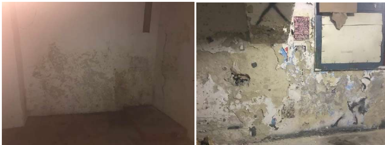
Sliki 8 in 9: Vidni sledovi prekomernega navlaževanja zidov v kleti in na pritličnem nosilnem zidu ob vhodni avli
