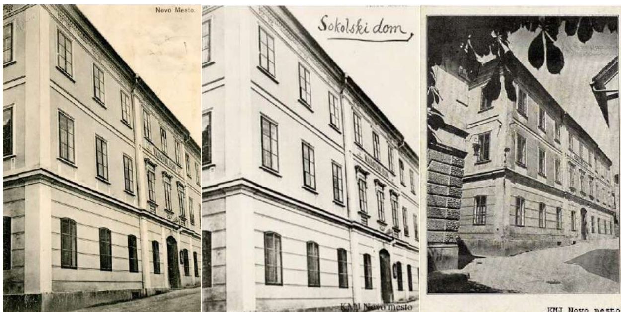
Slika 28: Fotografije Sokolskega doma – Narodnega doma Novo mesto (vir: Knjižnica Mirana Jarca Novo mesto): Po njih lahko ugotovimo, da se izvirni načrti (risba zgoraj) razlikuje od dejansko izvedene fasade: nekatera okna so bila zazidana in na fasadi zgolj nakazana, na območju odra, ker je bila svetloba moteča za gledališke in glasbene predstave in postavitve odrske tehnike in kulis.
