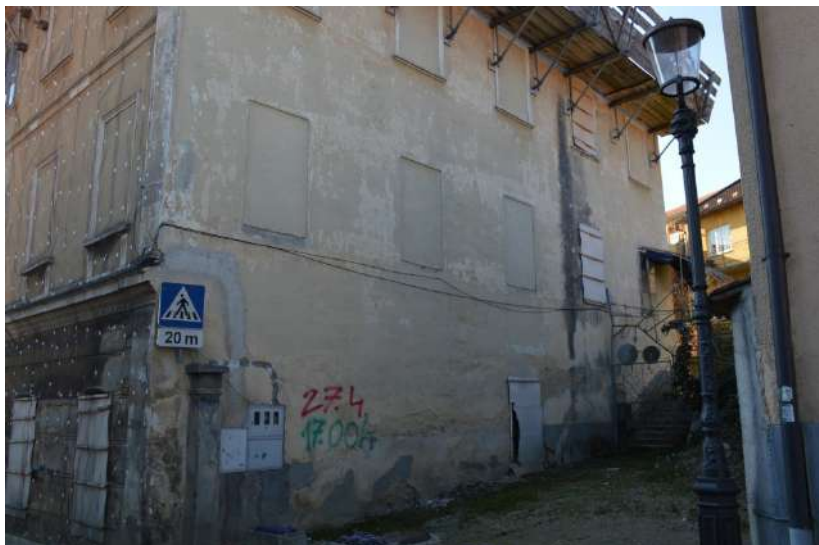
Slika 26: Severna fasada; luščenje ometov.
