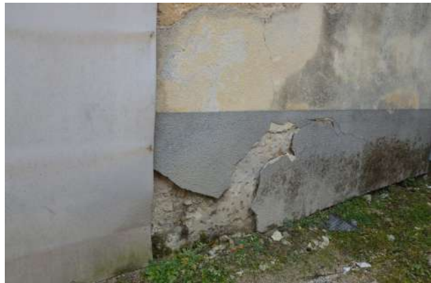
Slika 23,24: Cokel na severni fasadi je poškodovan; vidne so cementne plombe in odstopanje ometa.
