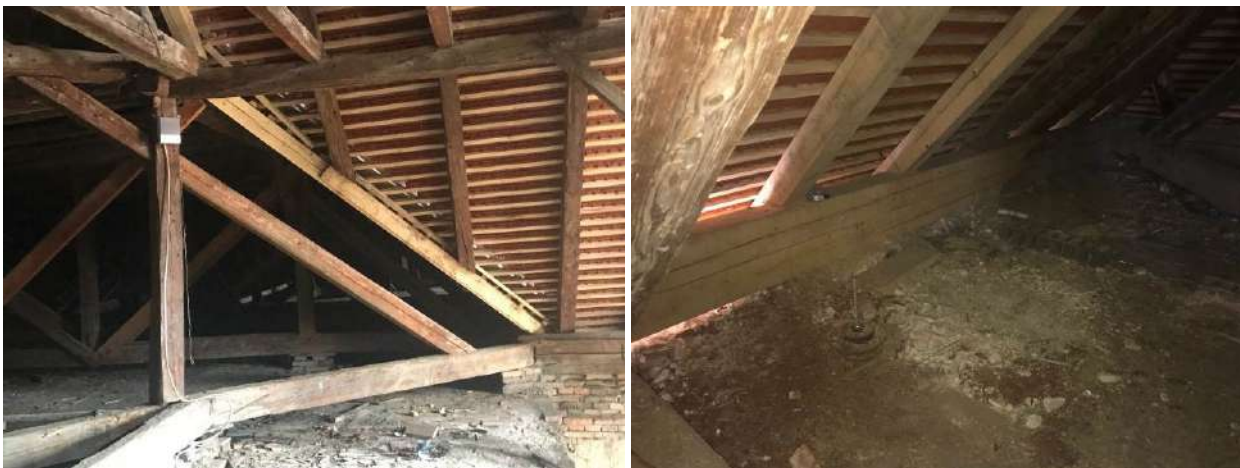
Sliki 16 in 17: Zamenjani - svteljši elementi strešne konstrukcije ter zamenjani špirovci s strešnimi letvami
