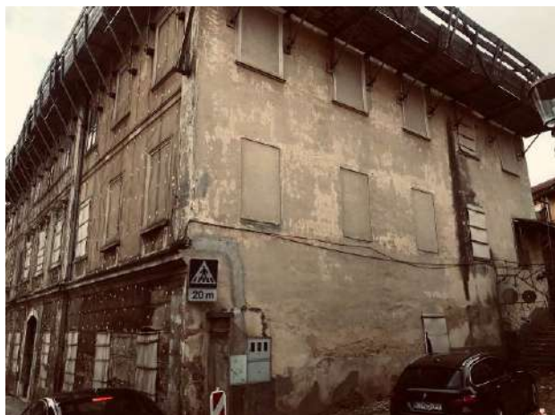
Sliki 6 in 7: Stanje fasadnih ometov na stranski Z fasadi in zmrzlinke poškodovani ometi na čelni fasadi
