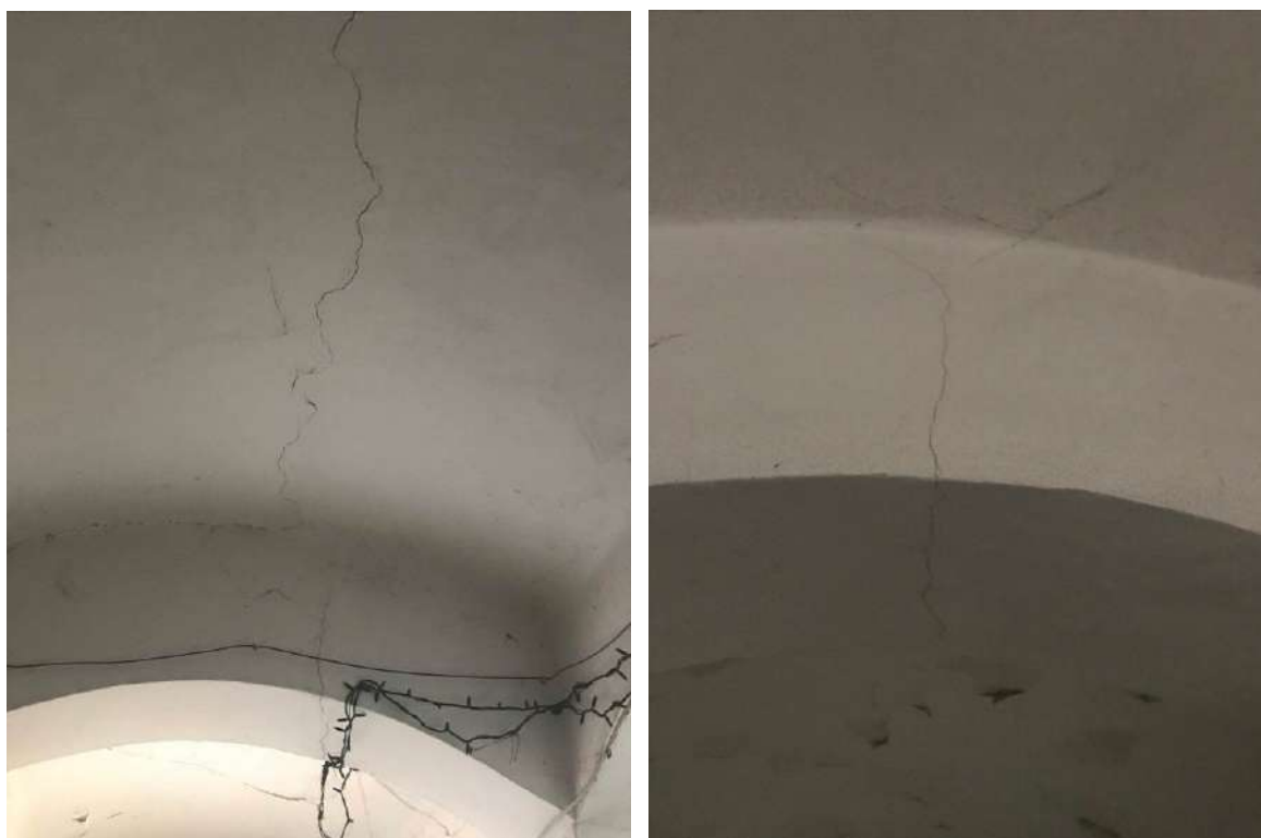
Sliki 10 in 11: Razpoke na opečnih obokih in lokih nad hodnikom 1. nadstropja
