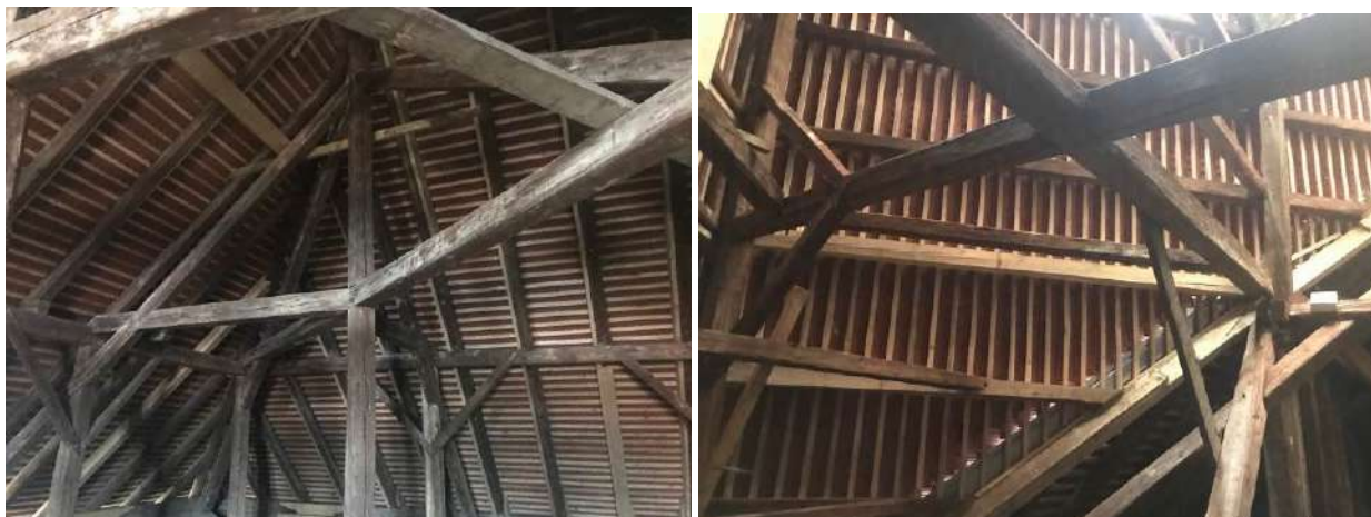
Sliki 14 in 15: Pogled na del strešne konstrukcije z vidnimi svetlejšimi strešnimi elementi, ki so bili zamenjani ali dodani v okviru prenove strešne konstrukcije v letu 2018
