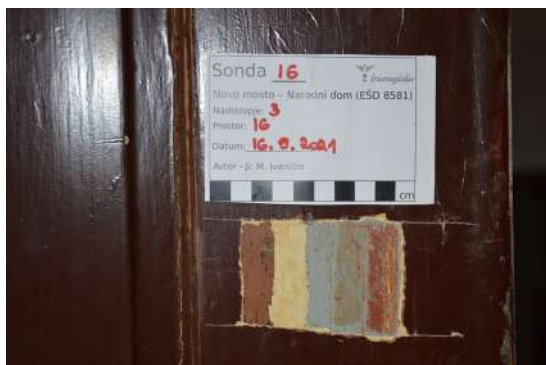
Slika 6: Velika dvorana in sonda na zgornjem notranjem okenjskem okvirju.
