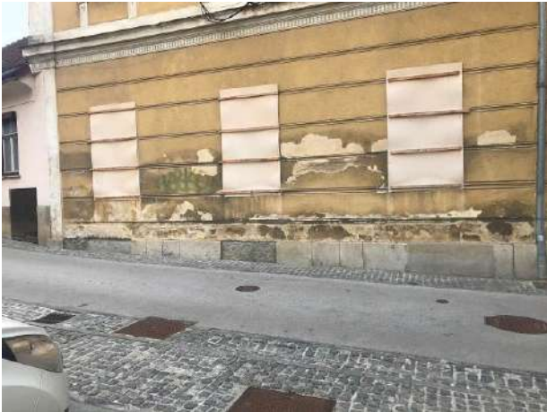
Slika 21,22: Kamnit cokel na južni in čelni fasadi, ki je razpokan in vidni znaki prekomernega navlaženja zidu ter odpadle kamnite plošče cokla.
