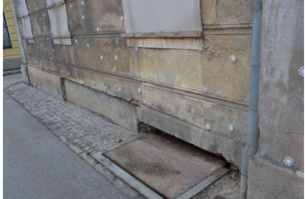
Slika 21,22: Kamnit cokel na južni in čelni fasadi, ki je razpokan in vidni znaki prekomernega navlaženja zidu ter odpadle kamnite plošče cokla.
