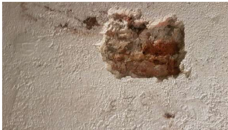
Sliki 28 in 29: Dva od desetih izvedenih sondažnih izsekov na zidovih ( pritličje in 1. nadstropje)
