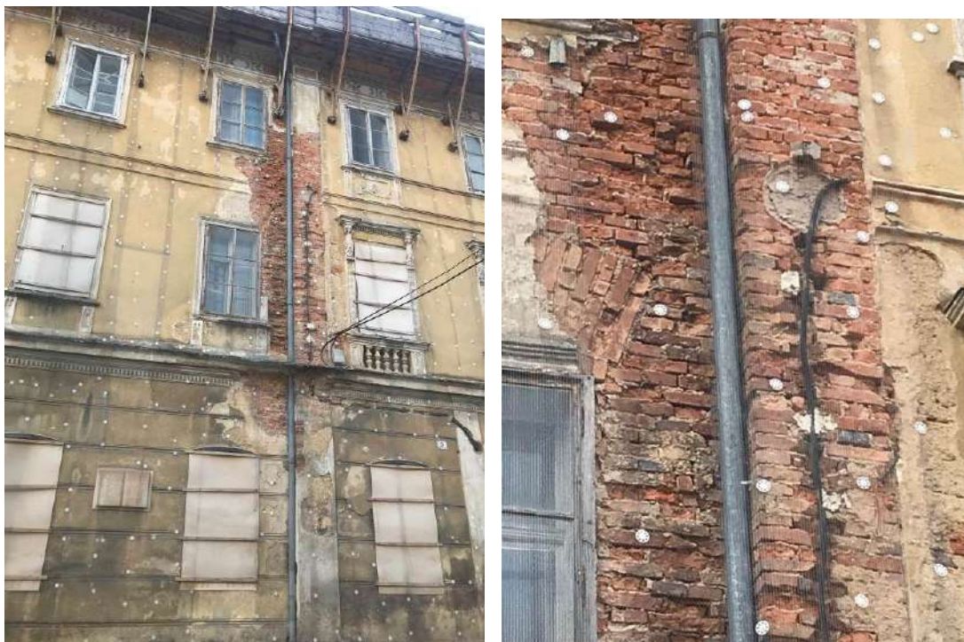
Sliki 2 in 3: Odpadanje fasadnih ometov in zmrzlinško poškodovani ometi na čelni fasadi ter zaradi zamakanja razgaljen opečni zid v liniji odtočne cevi, kjer so opečni zidaki in malta močnejše zmrzlinško poškodovani
