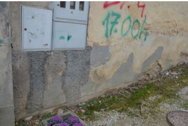
Slika 23,24: Cokel na severni fasadi je poškodovan; vidne so cementne plombe in odstopanje ometa.
